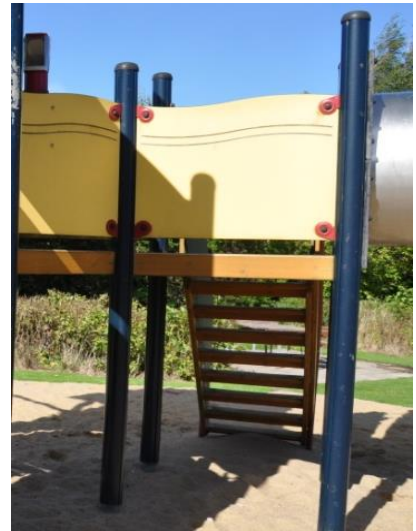
Her ses en gul sideafskærmning. Bemærk, at der ikke er trin eller kighuller, der kunne invitere til klatring.
