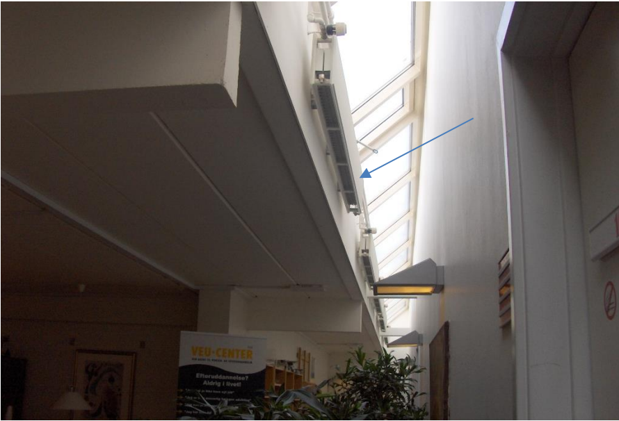
Vinduesrammer og radiatorer under loftet
