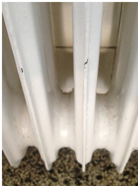
Støv på radiator
