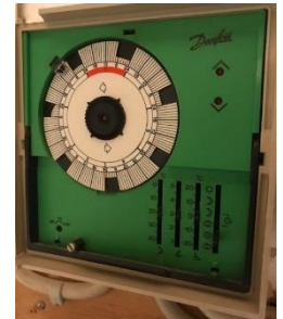
Ældre vejrkompeniseringsanlæg Foto: Kenneth Tække
