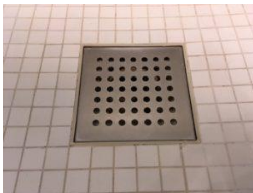
Afløb fra bruseniche
