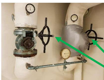
Afspærringsventiler (fjernvarme og brugsvand)
