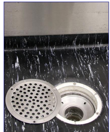
Foto: Gulv afløb på op-stue
