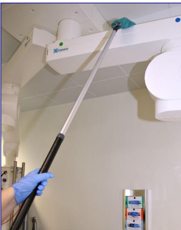
Foto: ventilation på op-stue
