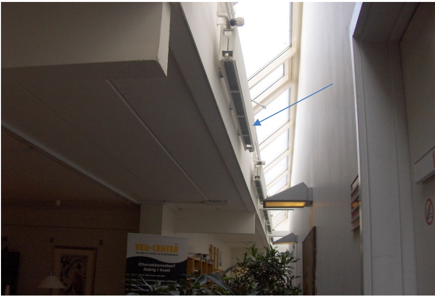
Vinduesrammer og radiatorer under loftet
