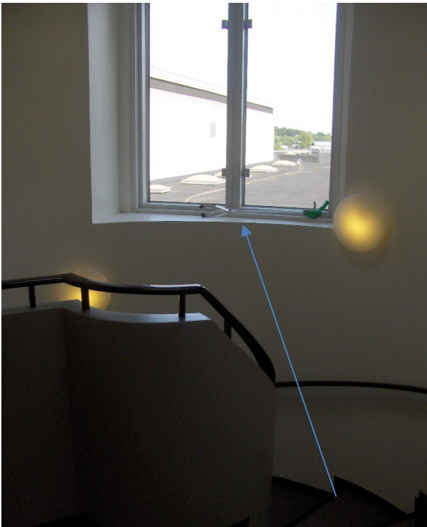
Rengøring af vindueskarm stående på trappetrinet.
