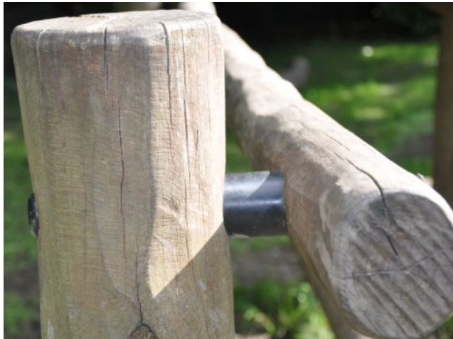
Afstandsklods, som forhindrer at beklædningsdele kan sætte sig fast
