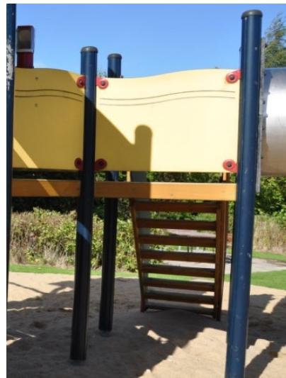
Her ses en gul sideafskærmning. Bemærk, at der ikke er trin eller kighuller, der kunne invitere til klatring.
